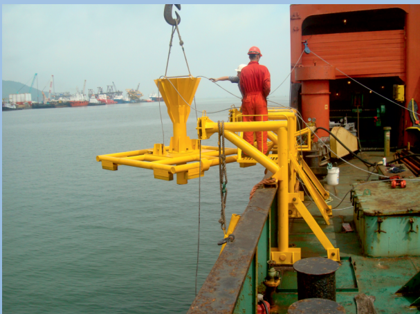
Монтаж набортного оборудования установки УМБ-130М на НИС «Триас», Вьетнам, 2009 г.
