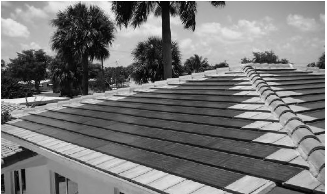
Рисунок 1.5 – Фотоелектричні плитки замінюють традиційну покрівельну черепицю
