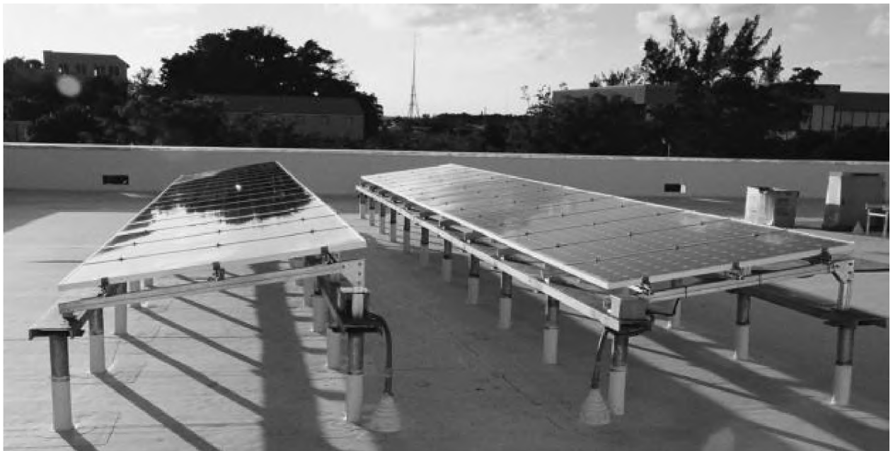
Рисунок 1.4 – Приклад кріплення рам на даху в зоні вітрів високої швидкості
