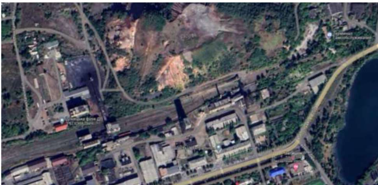
Рисунок 2.5. Аерофотознімок проммайданчику шахти «Центральна» ДП «Мирноградвугілля»
