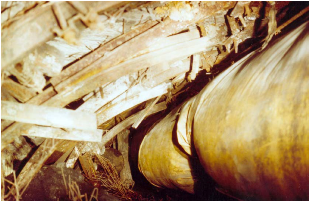
Рисунок 2.14 - Неефективність використання однорядної смуги при важкообвалюваній покрівлі виїмкового штреку [2]
