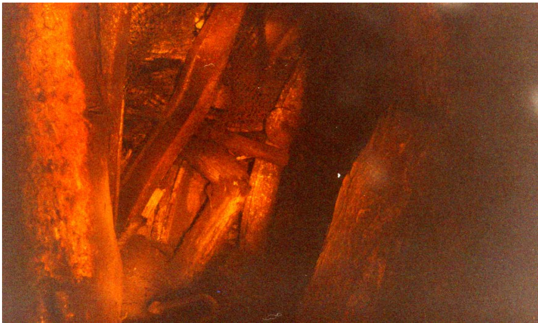
Рисунок 2.13– Результат дії бокового тиску на раму при легкообвалюваній покрівлі (а) та середньообвалюваній покрівлі (б) у 1- ому північному конвеєрному штреку блоку № 4 [2]
