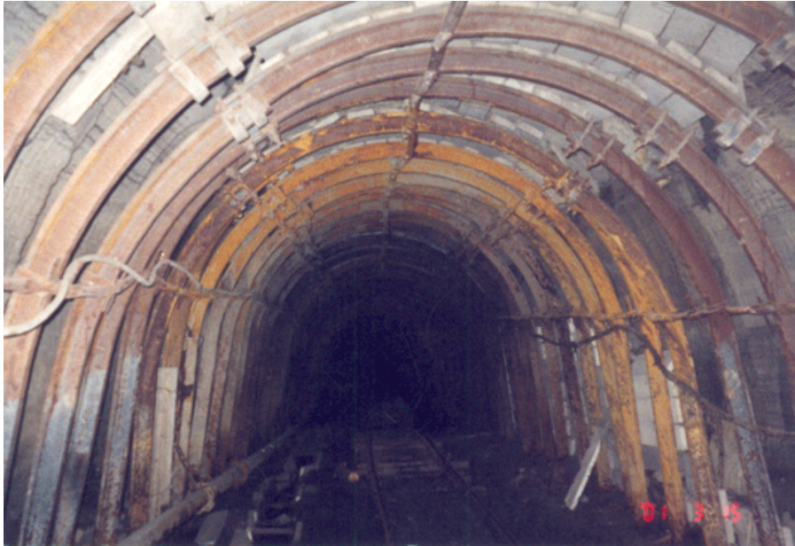
Рисунок 2.6 – Загальний вид кріплення КШПУ
