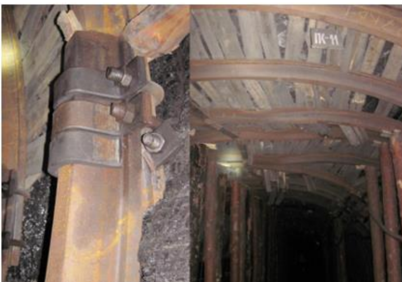
Рис. 2.12. Деформації металевих рам кріплення на ПК11 у південному конвеєрному штреку: а) розрив планки хомута замка; б) викладання
