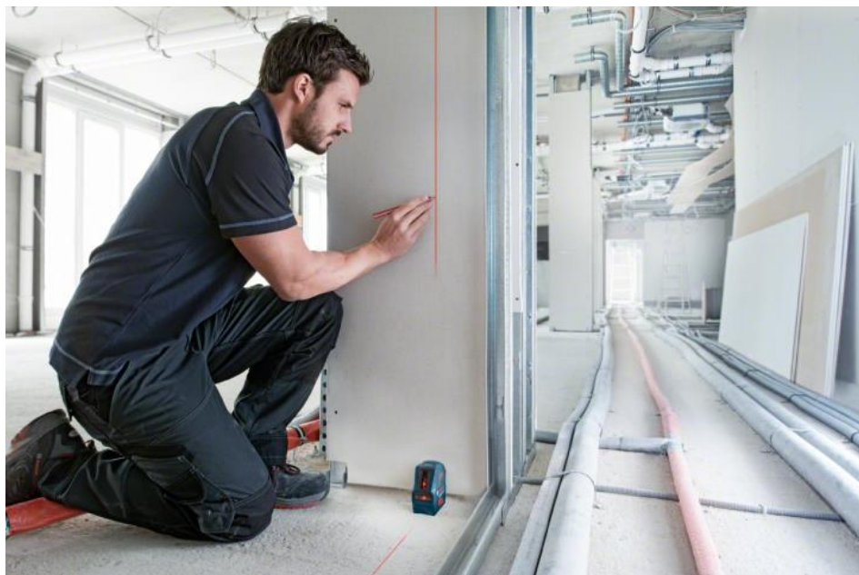
Рисунок 3.1.4 – Лазерний нівелір Bosch Professional GLL 2-10 в роботі
