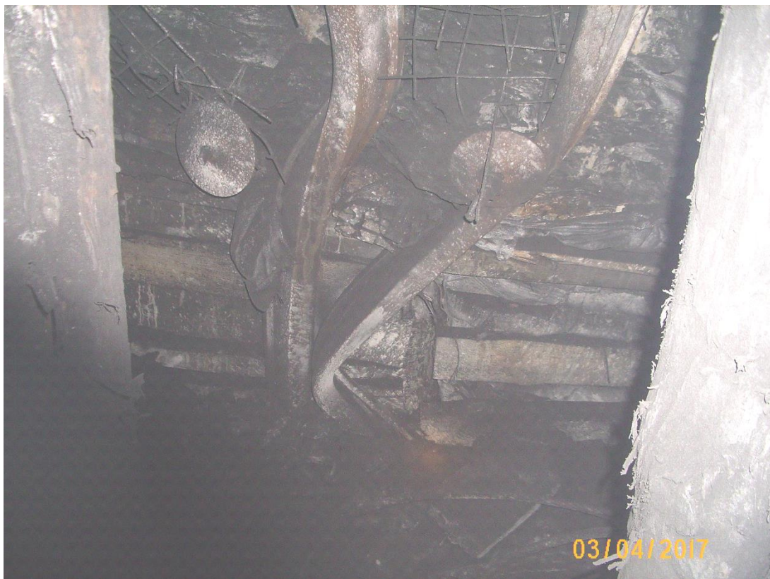
Рисунок 4.6. - Скручування профілю верхняка й стояків на контрольній ділянці
