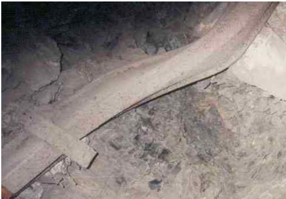
Рисунок 2.17. - Пластичний вигин профілю на ділянці максимального градієнту поздовжнього скручування (шахта ім. Героїв космосу)
