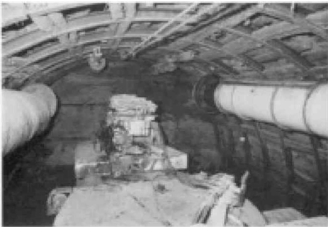
Рисунок 1.2. - Важкий каркасний тип рамно-анкерного кріплення, якій застосовувався на японських вугільних шахтах [Помилка! Джерело посилання не знайдено.]
