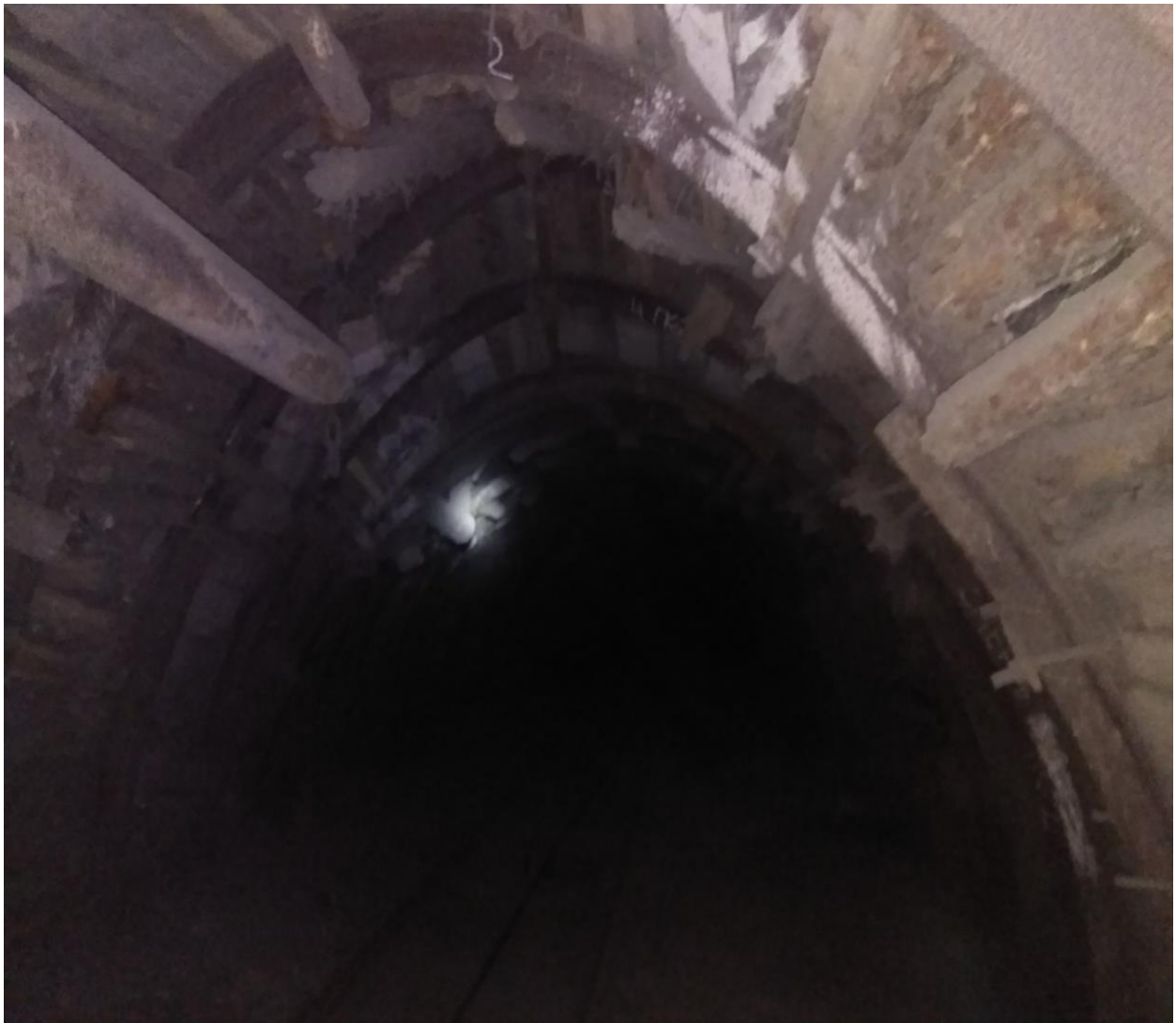
Рисунок 2.17 – Фото стану 12го вентиляційного штреку
