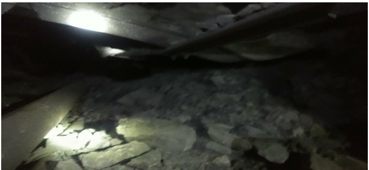
Рисунок 2.12 - Фото стану 12-го конвеєрного штреку після відкачки води
