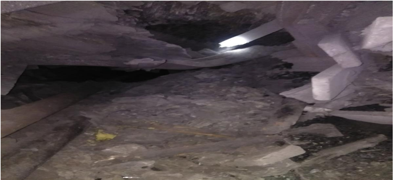
Рисунок 2.13 - Фото вивалу у 12-му конвеєрному штреку після осушення
