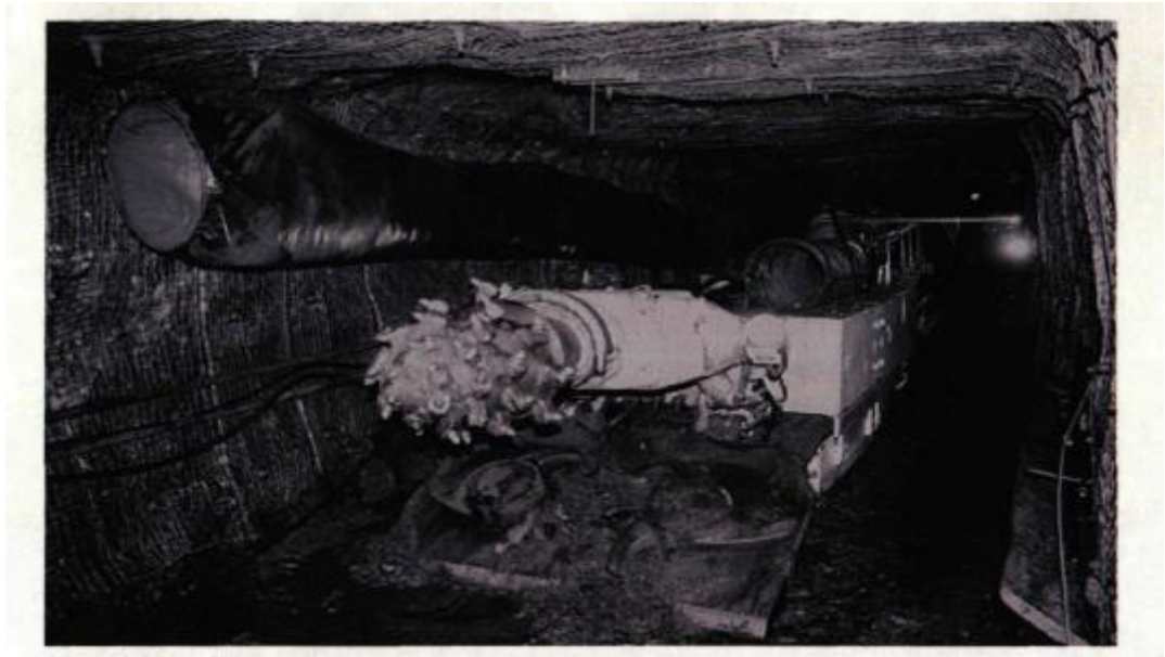
Рис. 4.20 - Система нагнітально-всмоктуючого провітрювання тупикової виробки (всмоктуючий трубопровід справа на комбайні)
