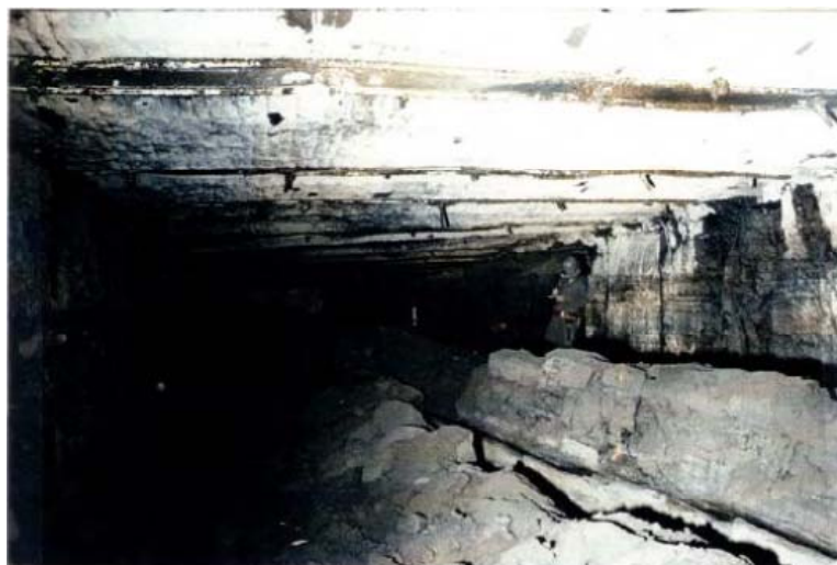
Рисунок 1.9 – Руйнування порід від вигину породної балки в підшві внаслідок набухання порід на Cooranbong in Newcastle Coalfield [12]
