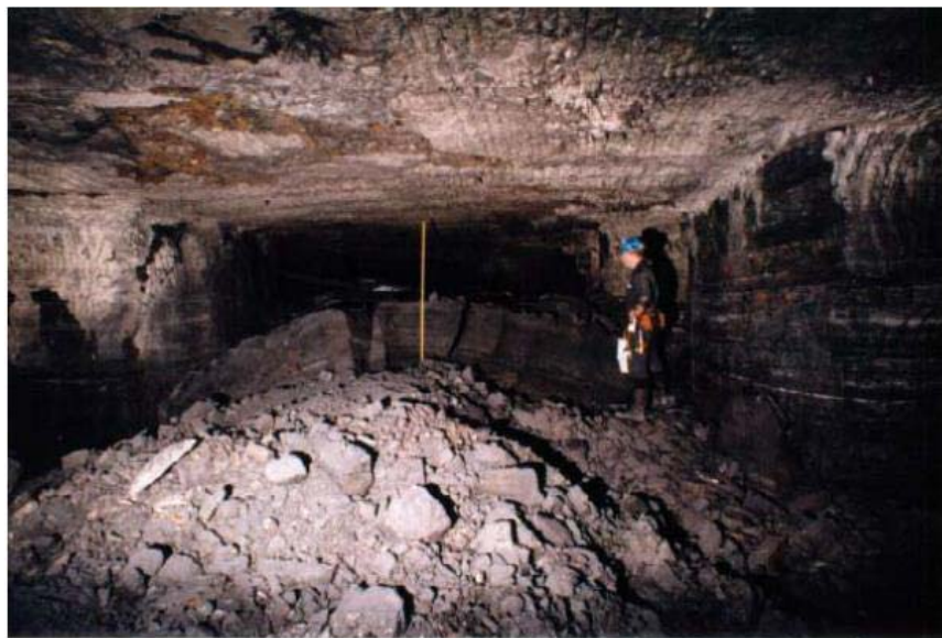
Рисунок 1.8 – Пучіння внаслідок набухання порід на Cooranbong in Newcastle Coalfield [15]
