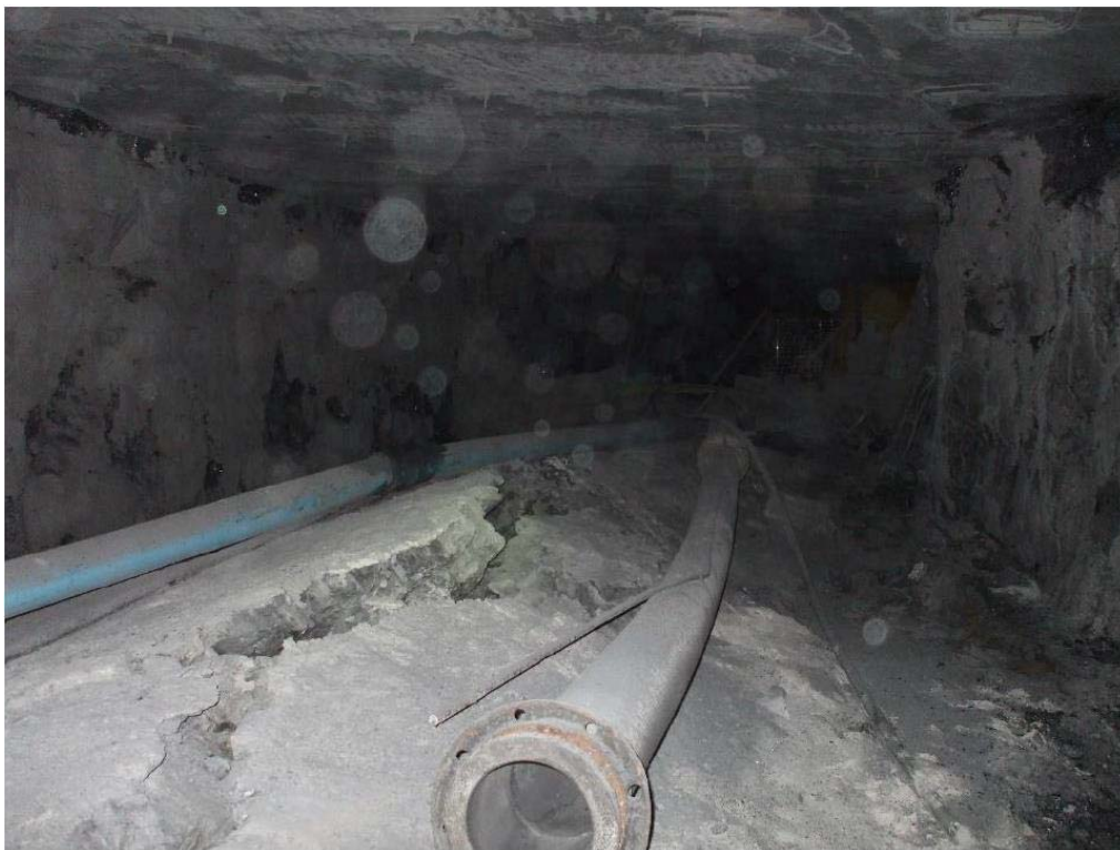
Рисунок 1.1 – Результат підняття порід підшви в штреці [2]
