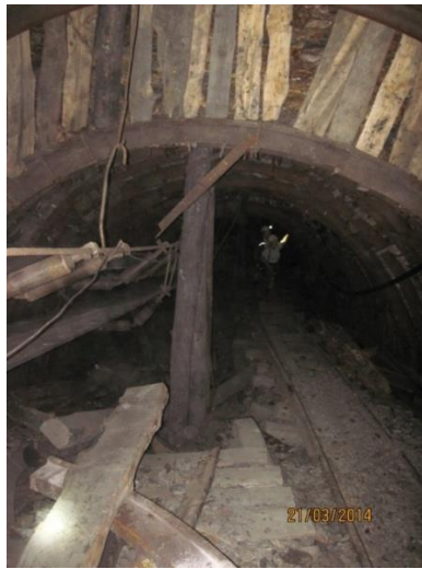
Рис. 2.5. Роботи з відновлення проектного перерізу у вантажному ходку
