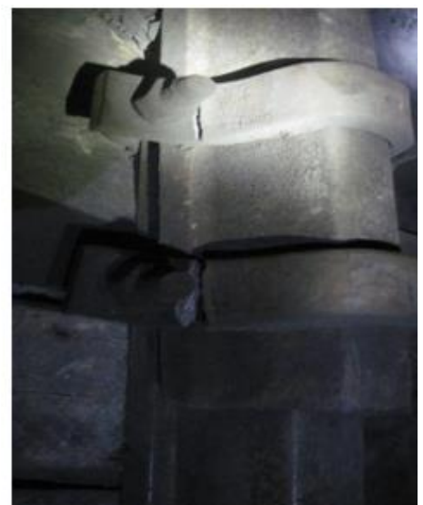
Рис. 2.12. Деформації металевих рам кріплення на ПК11 у південному конвеєрному штреку: а) розрив планки хомута замка; б) викладання
