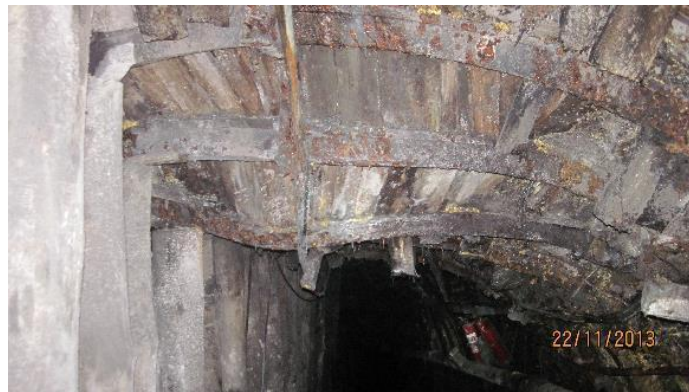
Рис. 2.6. Стан кріплення на ПК92 вантажного ходка ухилу №2: а) ліва сторона виробки; б) права сторона виробки
