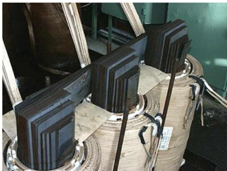
Рисунок 1.10 – Облаштування ізоляції обмоток трансформатора навколо осердя
