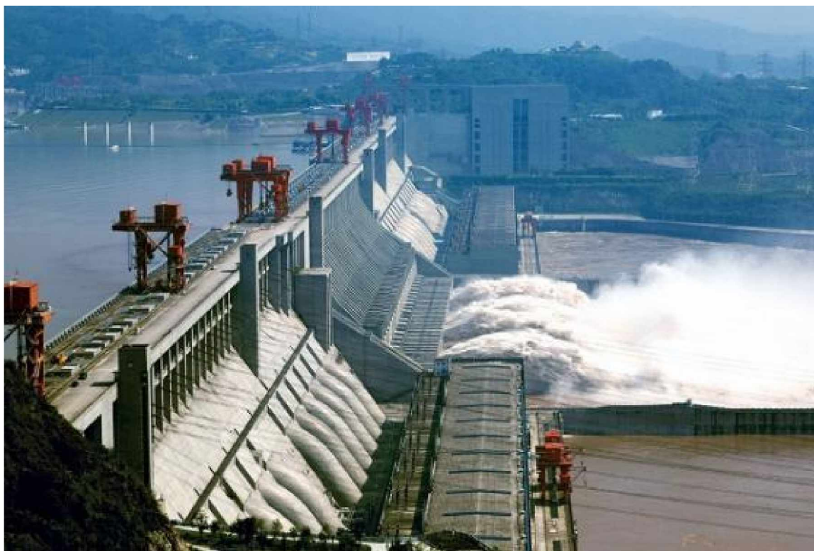
Рисунок 1.3 – гідроелектростанція «Три ущелини» (22,5 ГВт), р. Янцзи, Китай. Гребля: висота – 185 м, довжина – 2309 м.
