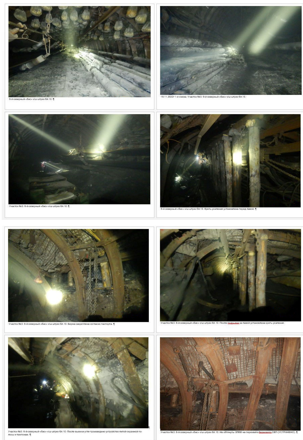
Рисунок 3.4 – Стан конвеєрного штреку при відпрацюванні 9-ї північної «біс» лави
