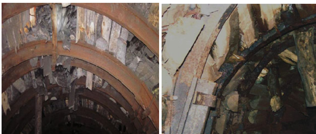
Рисунок 3 – Світлини наслідків проявів гірського тиску в умовах шахти «Криворізька» АТ «Криворізький залізорудний комбінат» на гор. 1315 м в маркшейдерських осях 130–136
