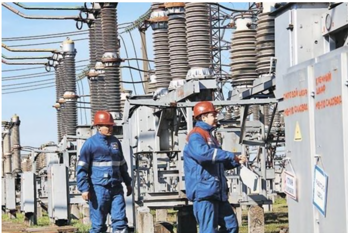
Рисунок 2.2 – Проведення модернізації електричного устаткування на розподільчій підстанції
