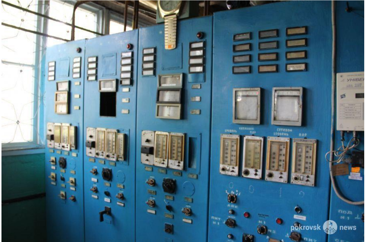
Рисунок 1.5 – Система контролю роботи котельні
