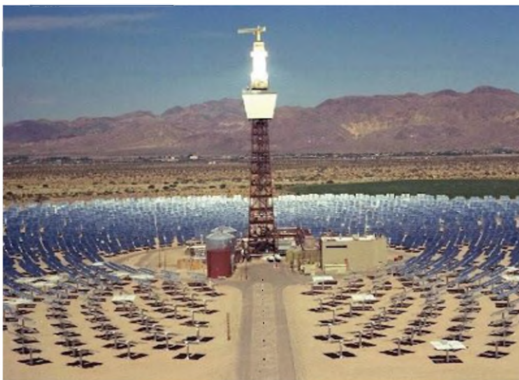
Рисунок 2.4 – Вежова сонячна електростанція
