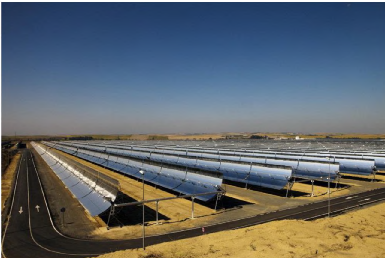
Рисунок 2.5 – Параболічна сонячна електростанція
