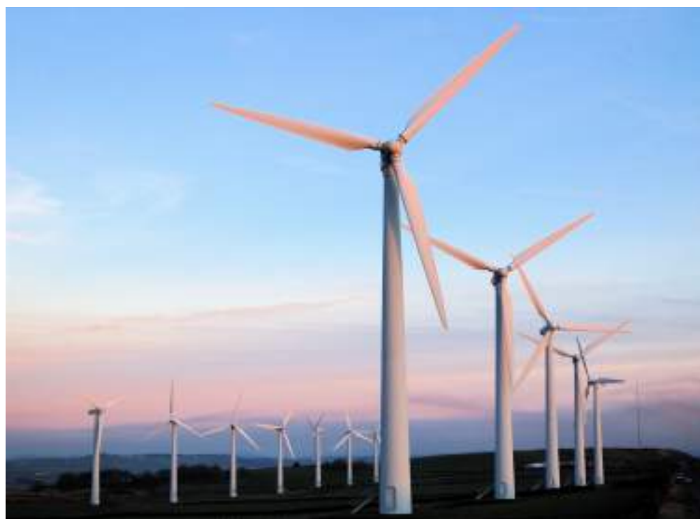
Рисунок 1.4 - ВЕУ - турбіна з горизонтальною віссю і числом лопатей від 1 до 3
