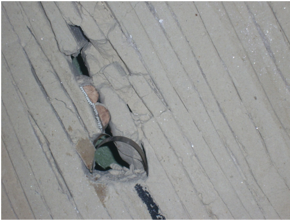
Рис. 1. Сдвигение боковых пород в окрестности штрека, при охране кустокострами
