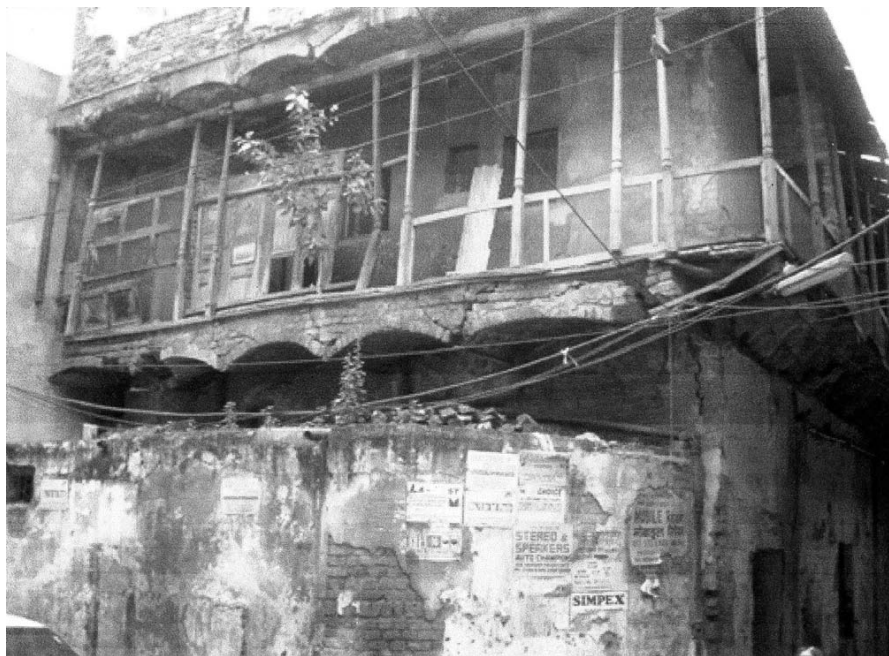
Рис. 8.44. Усиленное существующее здание в районе строительства станции метро
