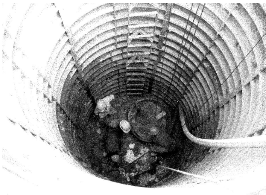
Рис. 8.43. Металлическая сегментная крепь ствола Hauz Qazi
