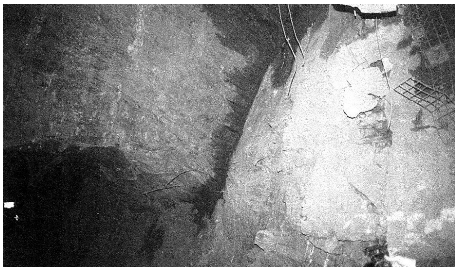
Рис. 2.76. Северная стена пересечения квершлага 326 со штреком
