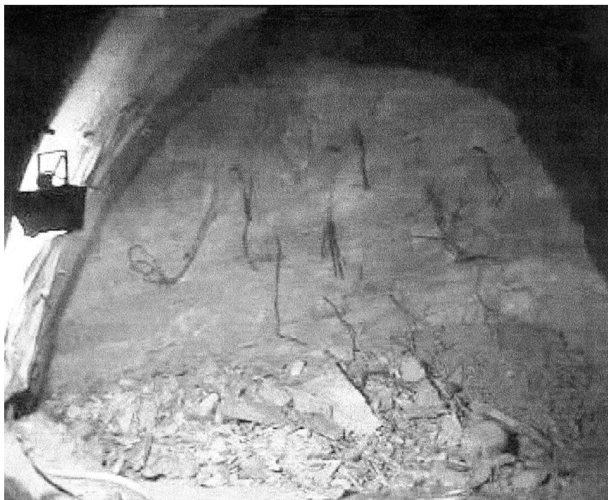
Рис. 4.17. Результат внезапного выброса в забое туннеля
