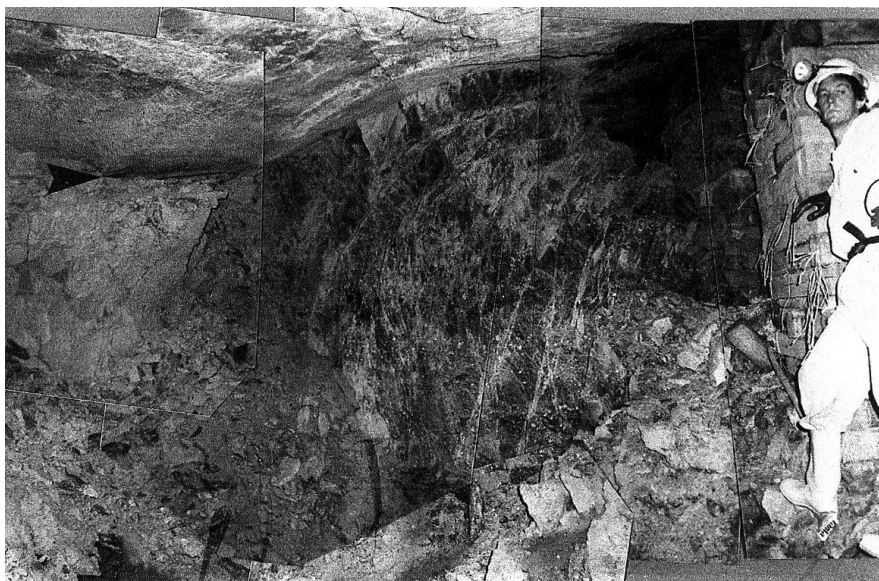
Рис. 1.34. Забой в точке Н (рис. 1.32), где произошли тяжелые повреждения
