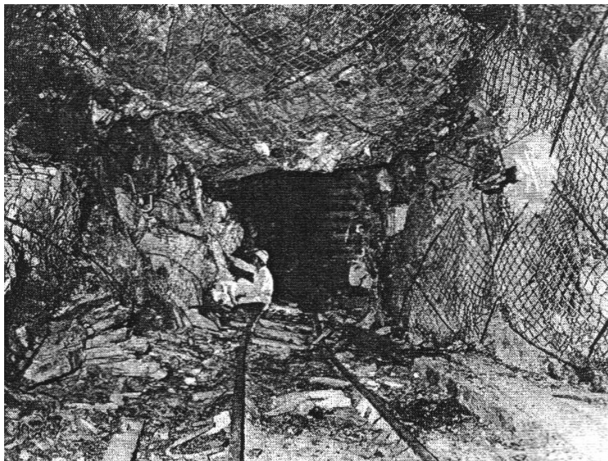
Рис. 4.25. Повреждения транспортной выработки 25 – №5N шахты Harmony Gold
