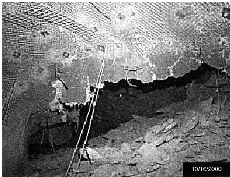
Рис. 2.73. Восточная бровка квершлага 326 после выброса октября 2000г.
