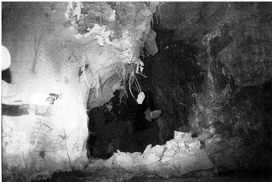
Рис. 2.75. Пересечение выработок рис. 2.74 с южной стороны после удаления отторгнутого материала
