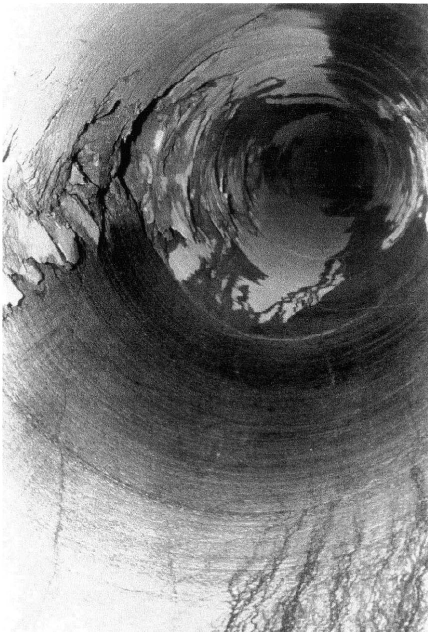
**Рис. 5.32. Повреждения в рудоспуске шахты Star**
