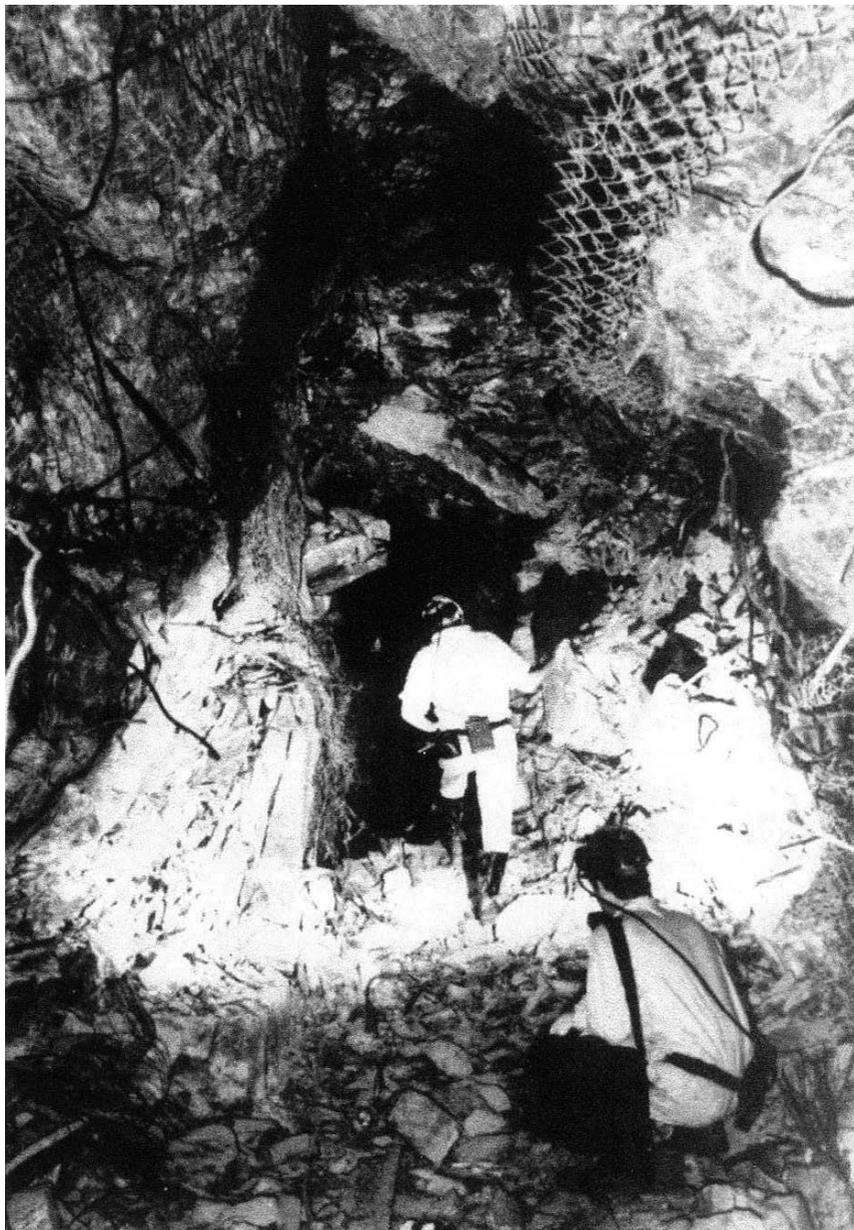
**Рис. 3.33. Повреждения в туннеле, вызванные внезапным выбросом (окончание)**
