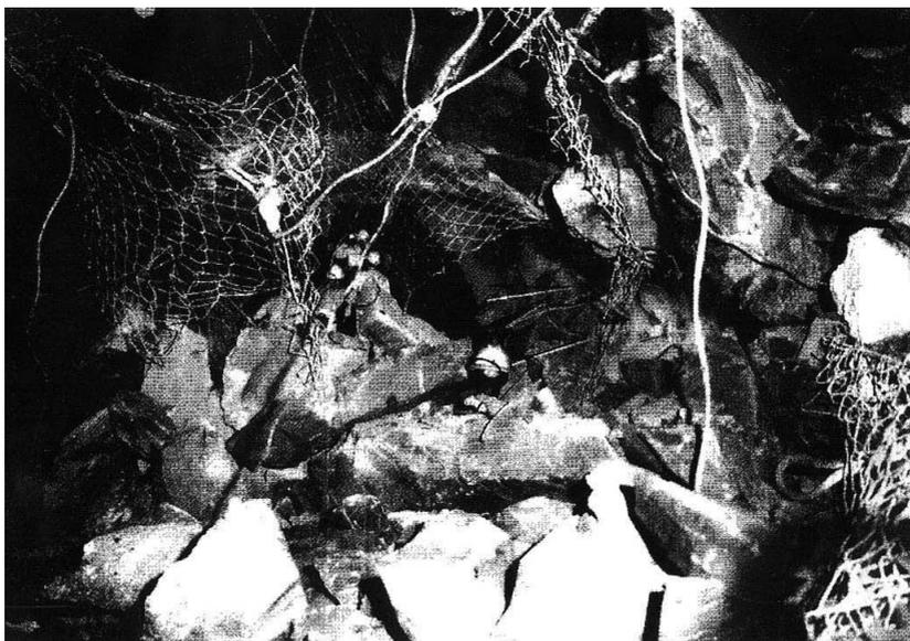
**Рис. 3.32. Разрушение набрызгбетонной крепи при внезапном выбросе в туннеле**
