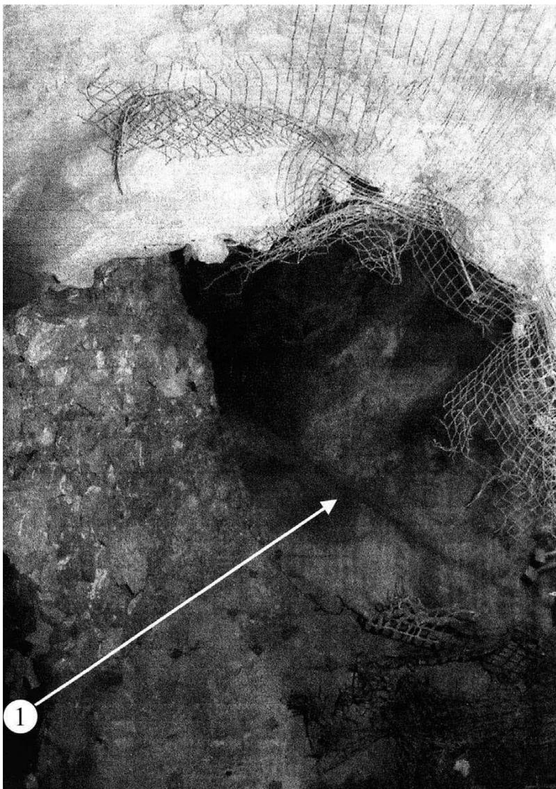
**Рис. 1.3. Расслоение пород и образование породных плит в туннеле под воздействием высоких напряжений (шахта Южной Африки, глубина 2,9 км) (окончание)**
