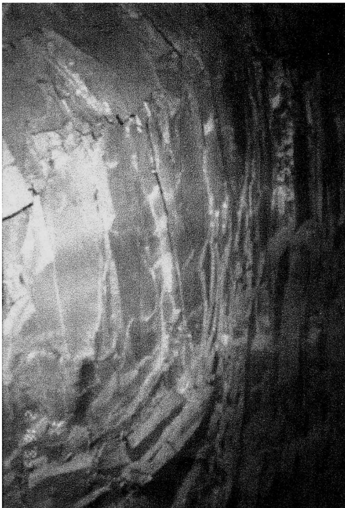
**Рис. 2.4. Расслоение и трещиноватость на поверхности туннеля**
