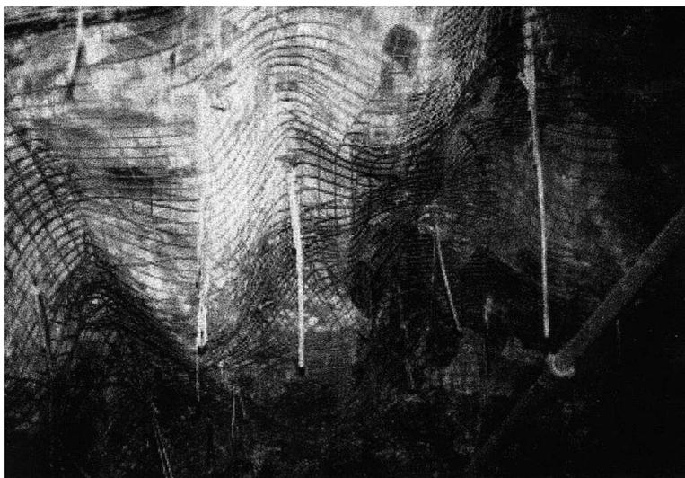
**Рис. 5.24. Последствия внезапного выброса в штреке**
