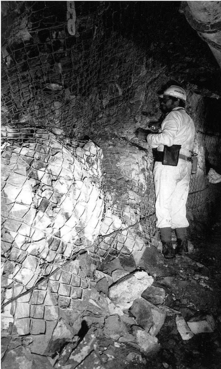
**Рис. 3.33. Повреждения в туннеле, вызванные внезапным выбросом**
