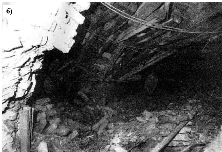
**Рис. 2.2. Состояние выработки, поддерживаемой продольными балками и кострами**
