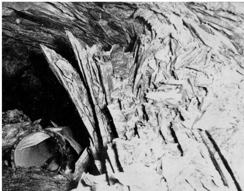
**Рис. 1.3. Расслоение пород и образование породных плит в туннеле под воздействием высоких напряжений (шахта Южной Африки, глубина 2,9 км).**
