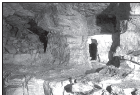
Цілики з вапняку для підтримання виробок
