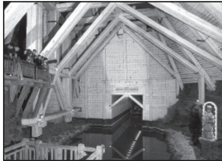
Просторові конструкції дерев'яного кріплення
