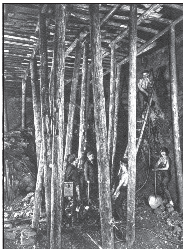
Стадія відбійки вугілля на пласті великої потужності при стовпівій системі розробки (Катовіце, початок XX ст.)
