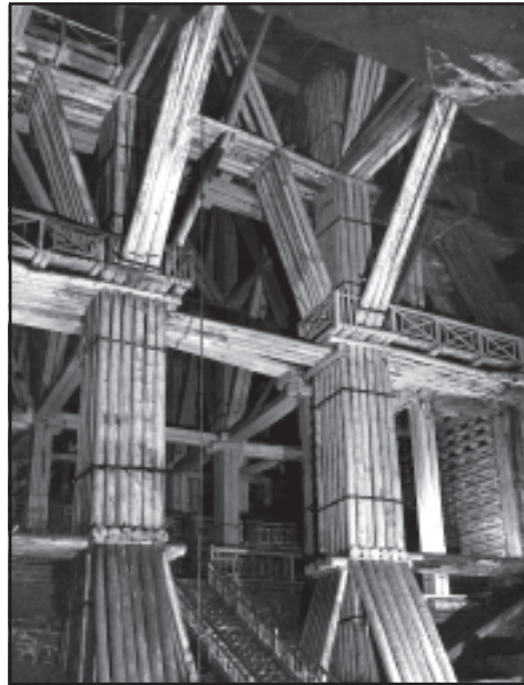
Дерев'яне кріплення в камері «Михаловіце»
