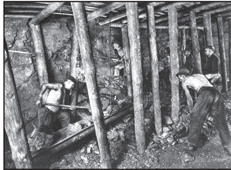
Роботи при стовпovій системі розробки з підвішеними жолобами (Катовіце, початок XX ст.)
