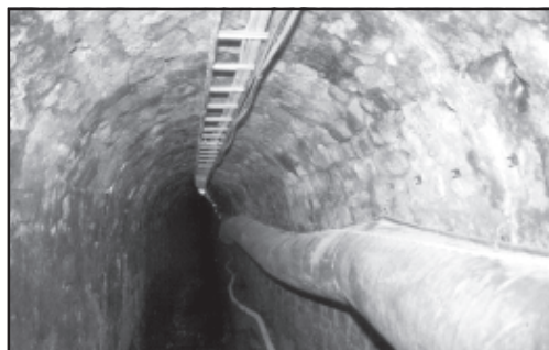
Ділянка з мурованим кріпленням (споруджена у 1806 р.)
