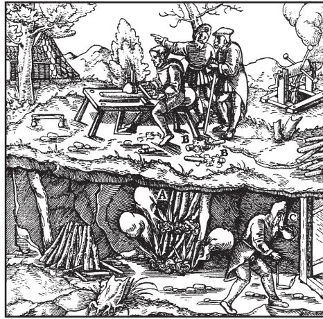
Застосування вогню при руйнуванні порід (за Г. А'ріколою, 1556 р.)
