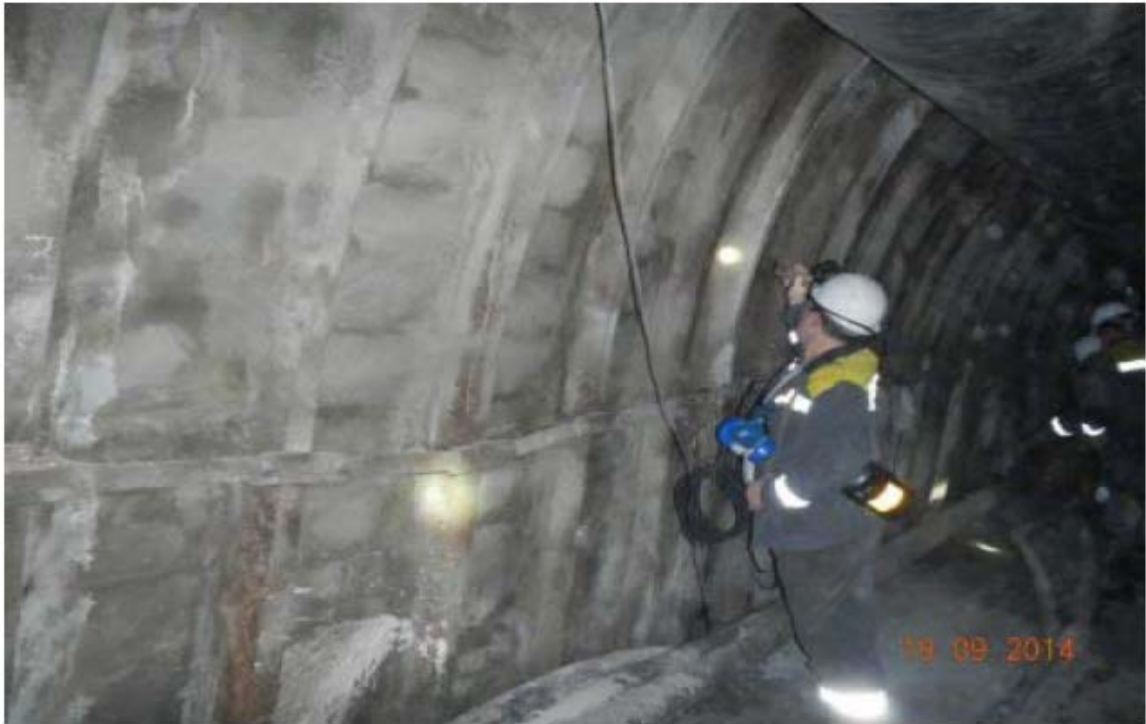
Рисунок 4.1 – Стан 1-го західного магістрального конвеєрного штреку гор. 370 м шахти ім. Героїв космосу, проведеного з тампонажем закріпного простору [8]
