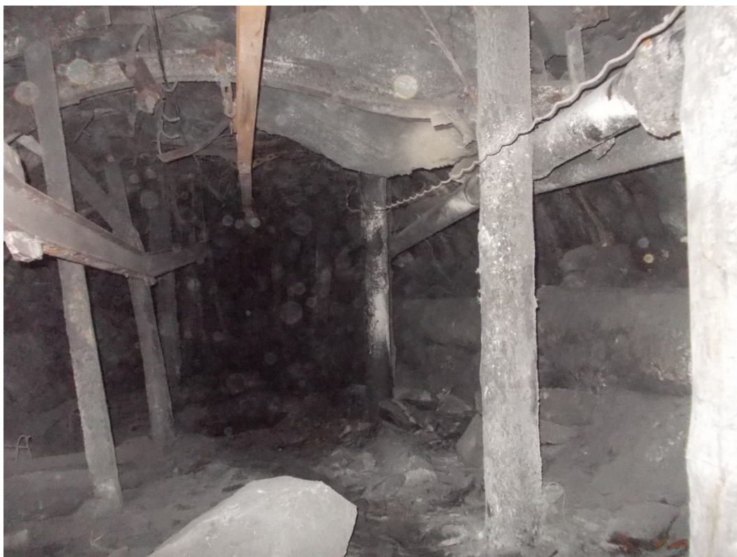
Рисунок 1.10 – Стан конвеєрного штреку за лавой в зоні сталого тиску
