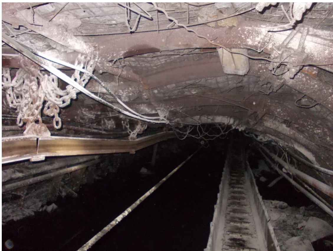
Рисунок 1.7 – Стан конвейерного штреку 20 м перед лавой
