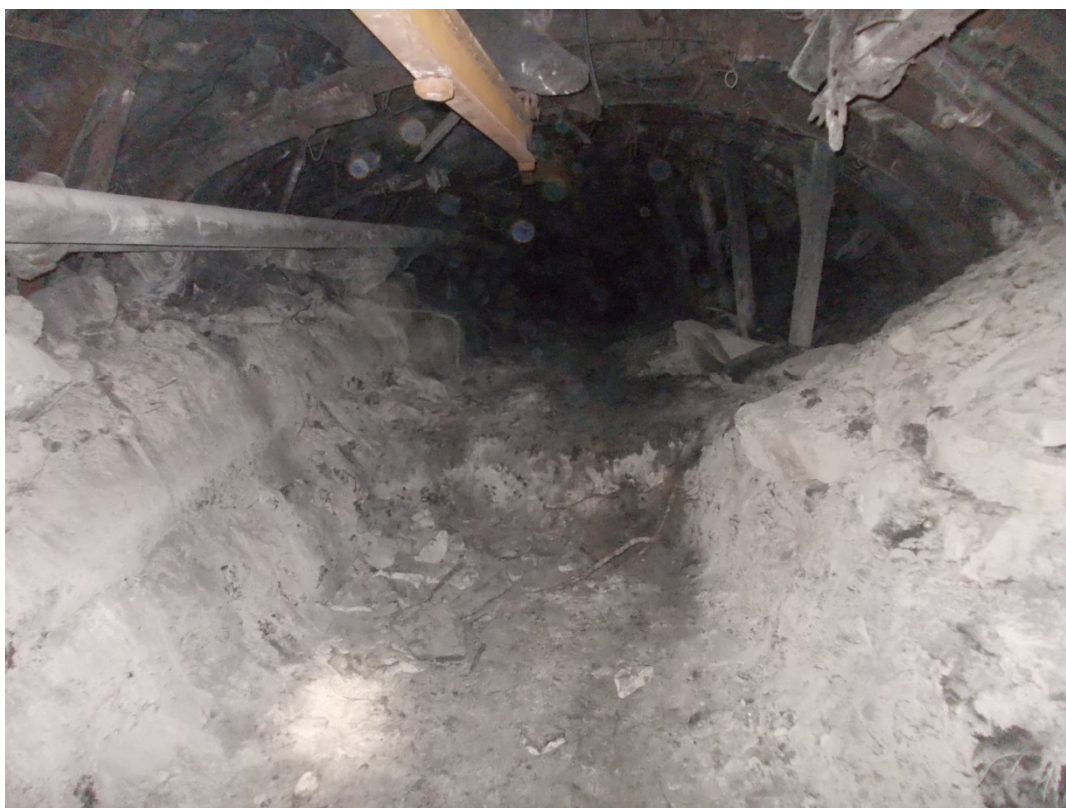
Рисунок 1.8 – Стан конвейерного штреку 12 м за лавой
