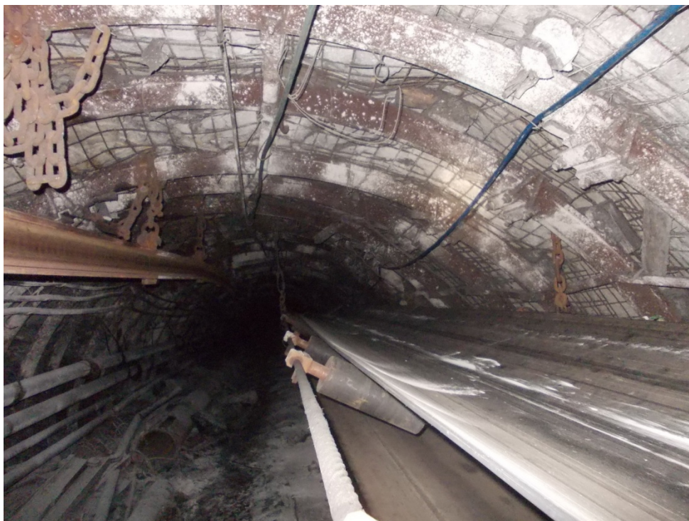
Рисунок 1.6 – Стан конвеєрного штреку 80 м перед лавой
