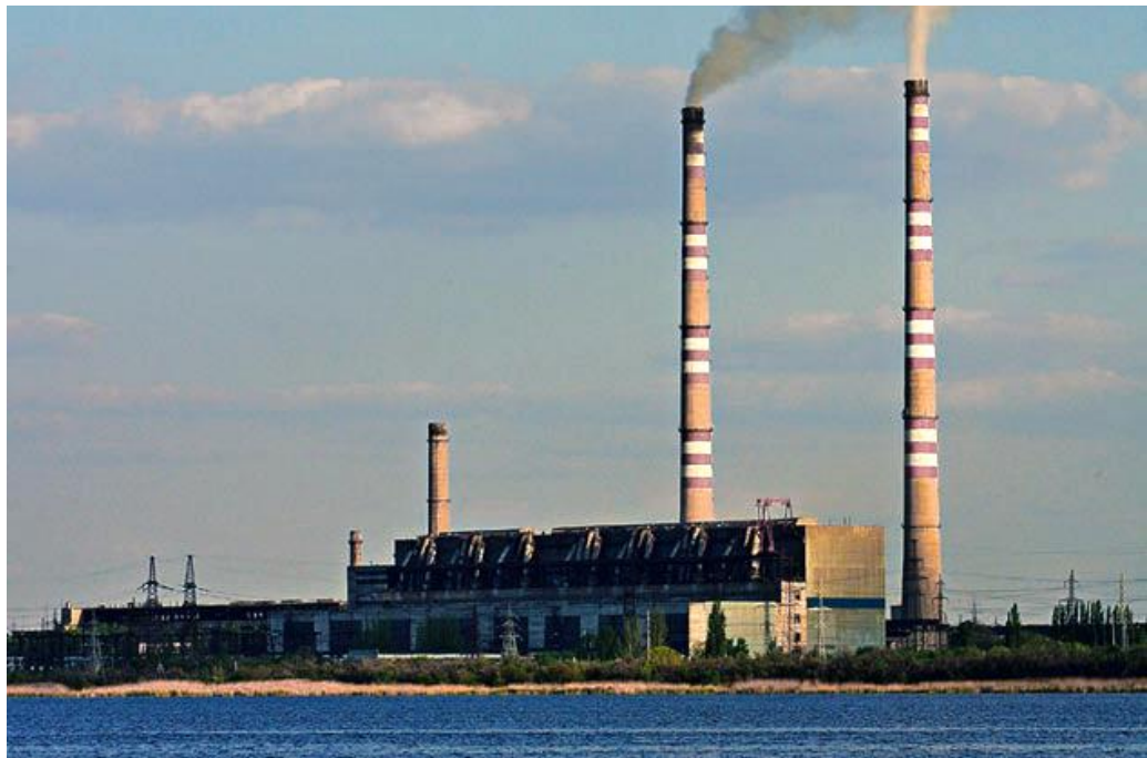
Рисунок 1.2 – Курахівська теплова електростанція
