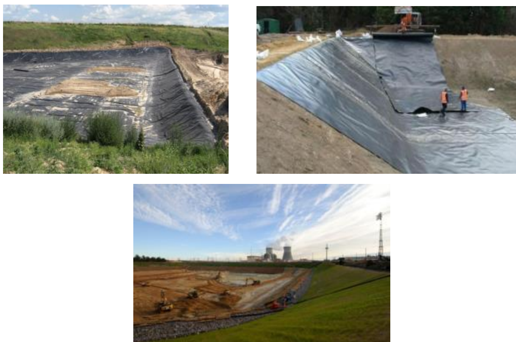
Рисунок 1.5 – Облаштування герметичного шару під полігон ТПВ (фото)
