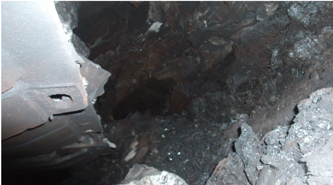
Рисунок 2 – Купол обвалення над секціями механізованого кріплення
