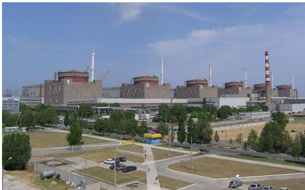
Рисунок 1.4 – Діючі енергоблоки атомної електростанції в Україні (ілюстративне фото)
