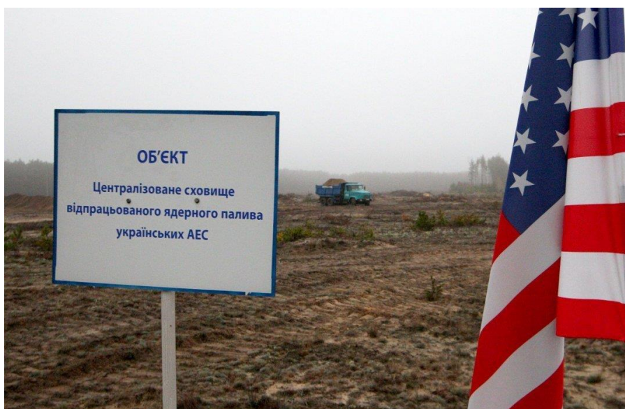
Рисунок 1.5 – Будівничий майданчик для централізованого сховища для відпрацьованого ядерного палива на основі західного досвіду (ілюстративне фото)
