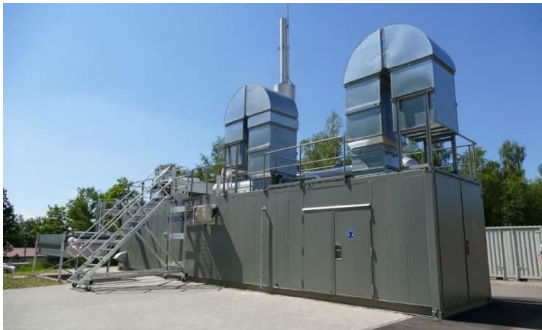
Рисунок 2.6 - Когенераційна установка в контейнерному виконанні
