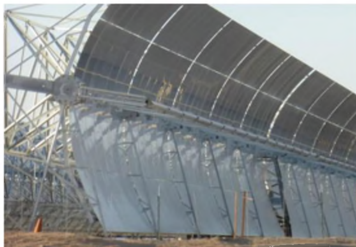
Рисунок 1.3 – Параболоциліндрична концентраторна СЕС
