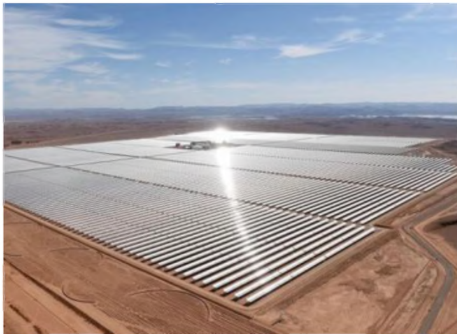
Рисунок 1.4 – Параболоциліндрична концентраторна СЕС в пустелі Сахара
