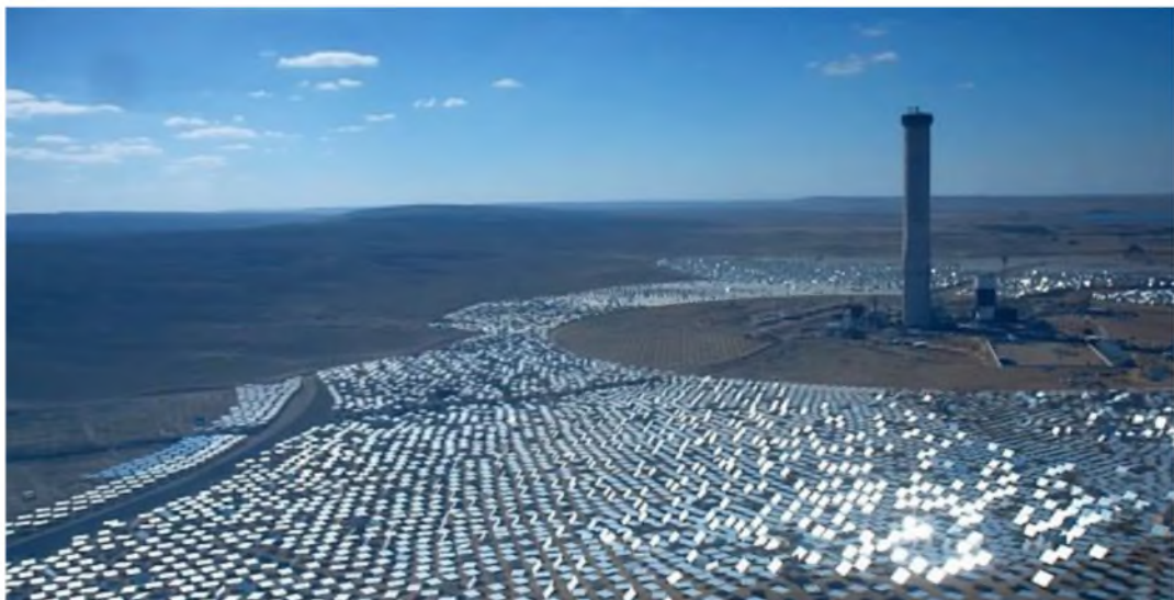
Рисунок 1.1 – СЕС баштового типу
