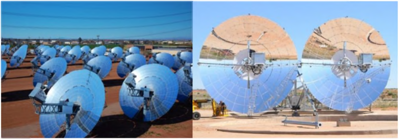
Рисунок 1.2 – Тарільчаста конструкція СЕС
