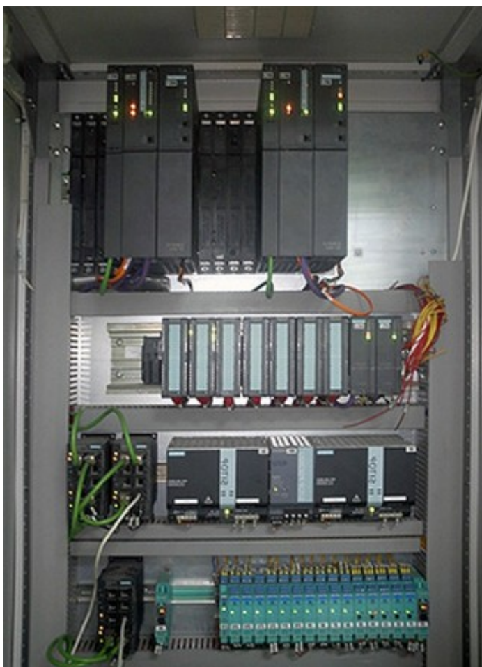
Рисунок 4.1 – Зовнішній вигляд апаратного з'єднання Siemens S7-300 і ET200M
