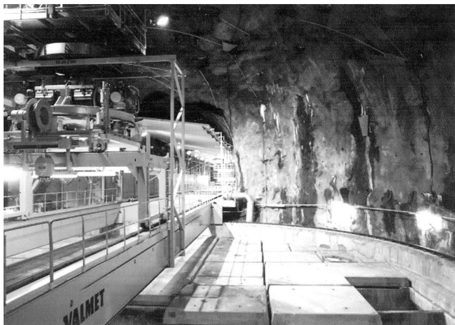
Рис. 5.176. Работы по строительству вертикального бункера
