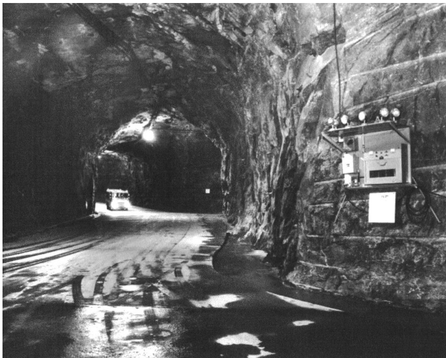
Рис. 5.42. Строительство трансформаторного зала электростанции Churchill Falls
