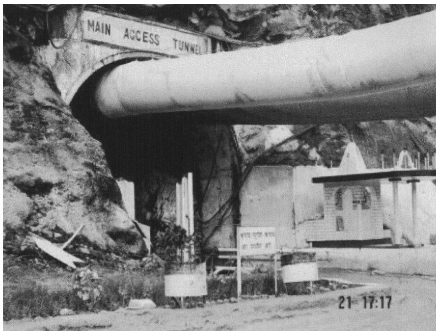
Рис. 5.12. Портал туннеля доступа электростанции Teesta
