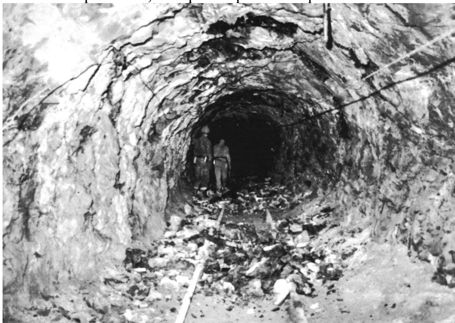
Рис. 4.10. Применение набрызгбетона для сильно расчлененных пород
