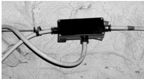
Рис. 1. Випромінююча кабельна мережа в шахті
