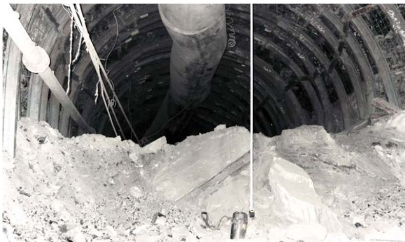
Рис. 1 – Характер проявления пучения пород почвы в 8-м вост. конв. штреке пл. m_3
